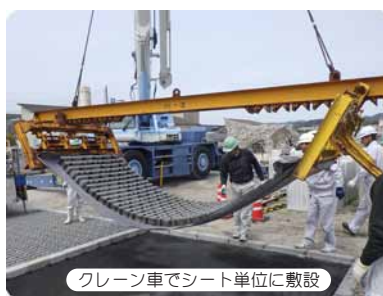
SRブロックをシートに接着固定
